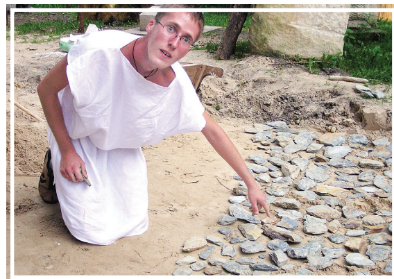
Michał Rybak przy kładzeniu drugiej warstwy (rudus) budowanej drogi fot. Jacek Mielcarzewicz
